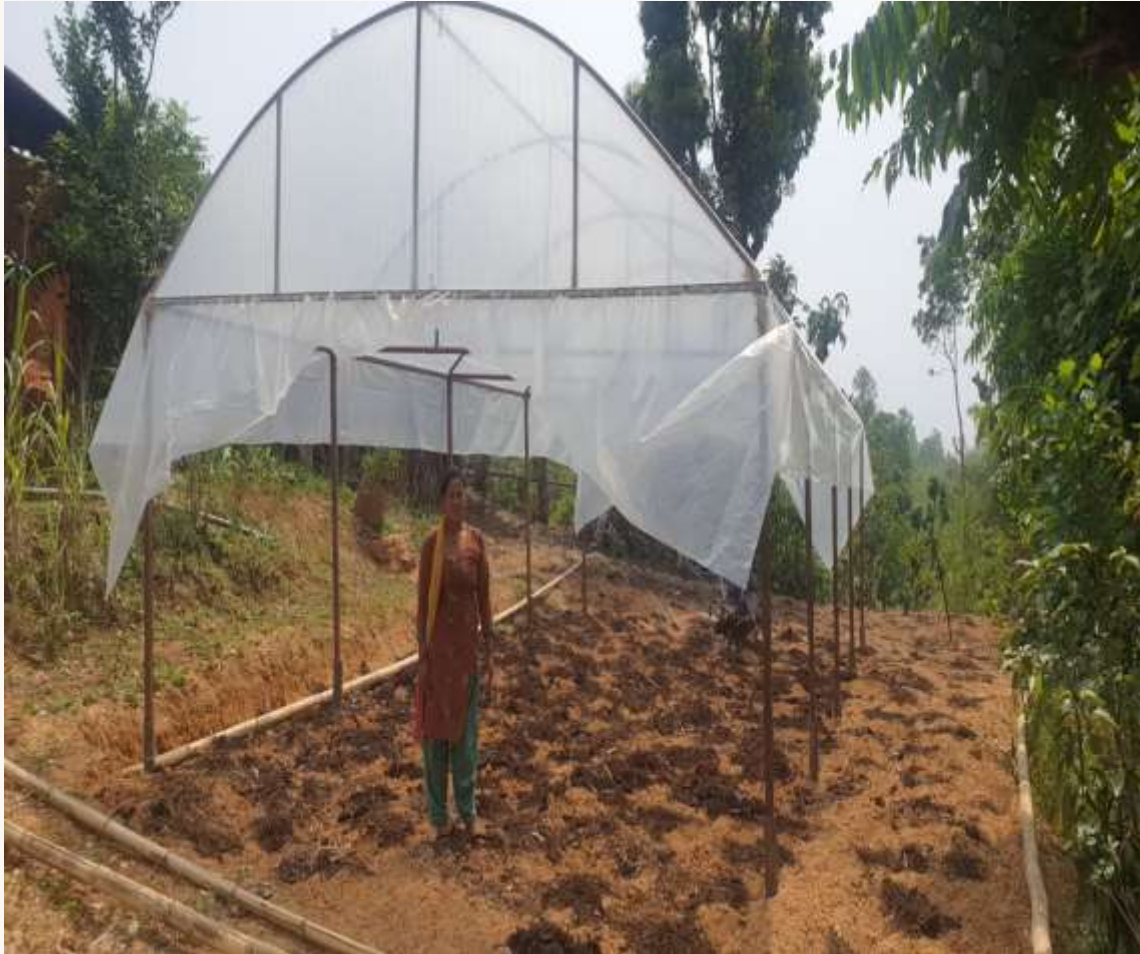
तरकारी खेतीको लागि टनेल निर्माण
